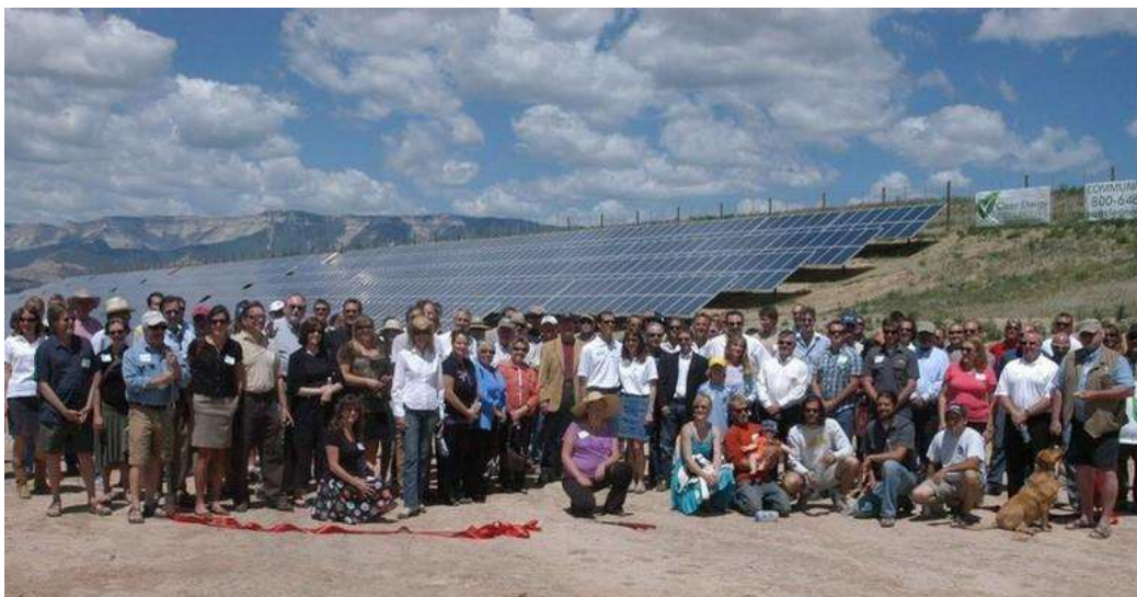
Komunitně vlastněná solární elektrárna o výkonu 858 kW na letišti Garfield County ve státě Colorado.
